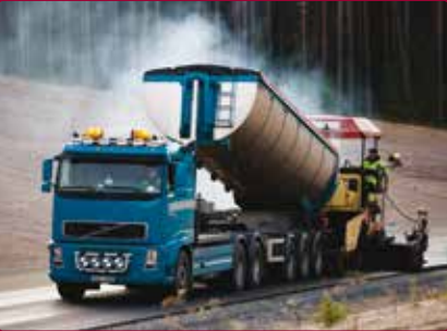
Asfaltna baza Hardox® 450/500/550 kao obloge i u kliznim stazama za šljunak. Hardox® 450/500 u krilcima bubnja. Hardox® 450/500 u transportnom spremniku od bubnja do dopremnog vratila kamiona.
