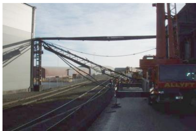
Nedkörning av ledningsstråk
