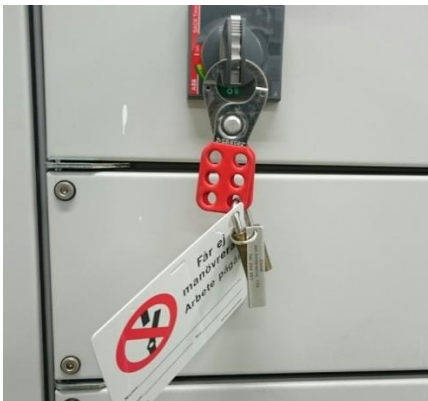
Säkerhetsbrytare med sax och personligt skyddslås (id.märkt)
