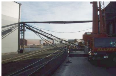
Nedkörning av ledningsstråk
