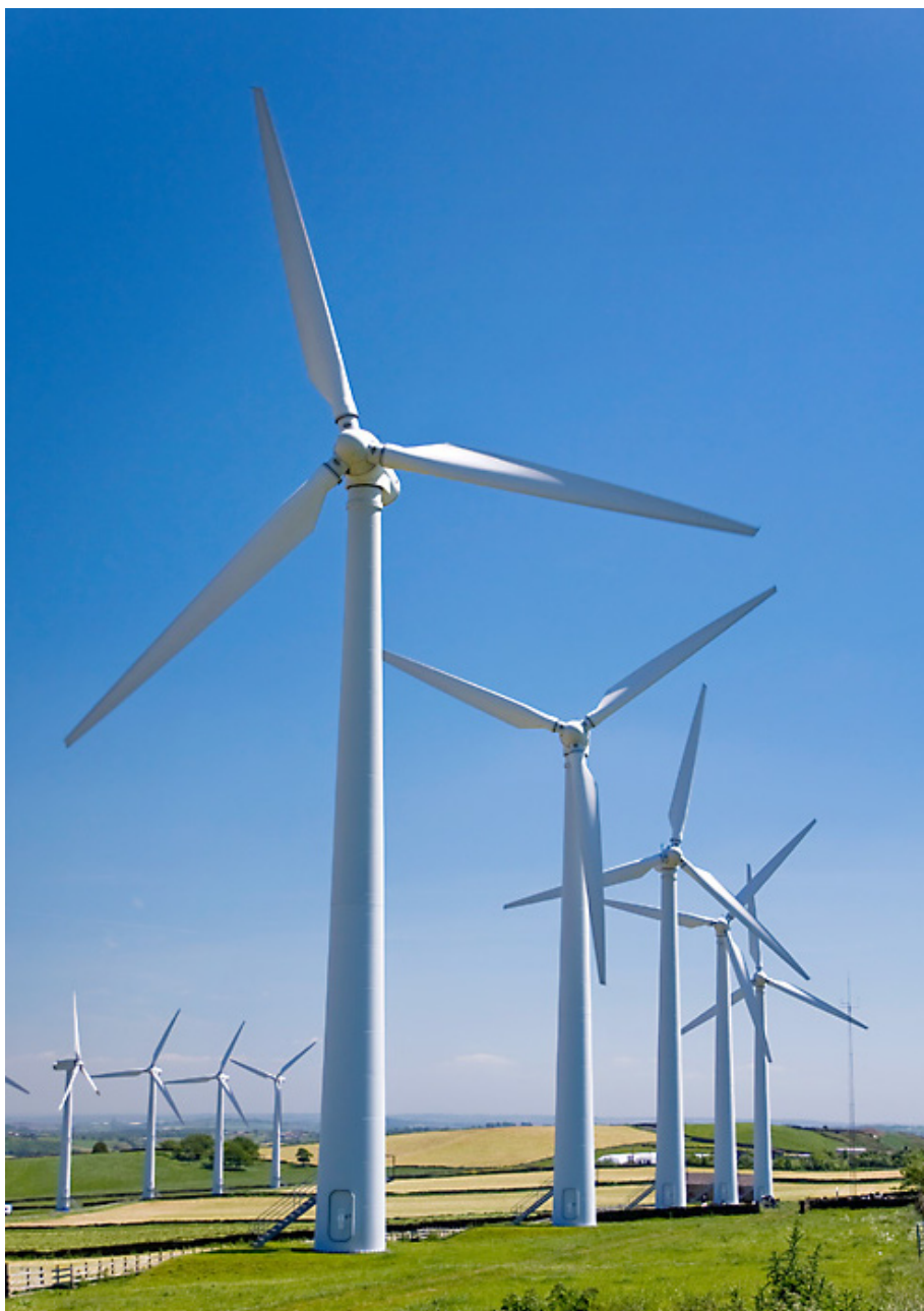
I Montpelier, Iowa, undersöks vindkraft som energikälla.
