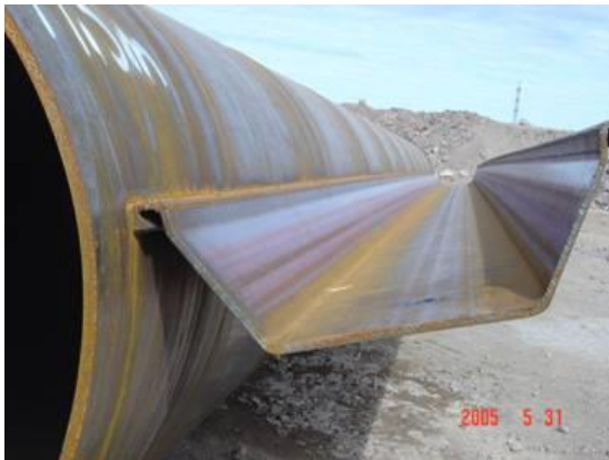
Rys.7. Grodzice przyspawane bezpośrednio do pali nośnych
