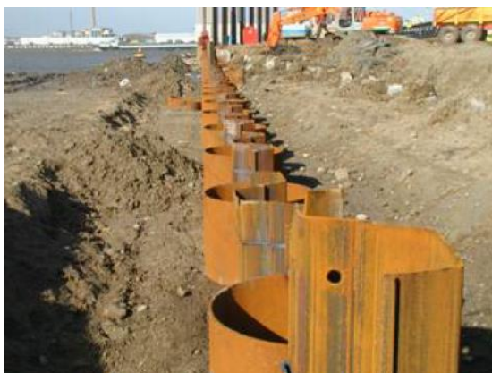
Rys. 3. Ściana kombinowana w konstrukcji nabrzeża
