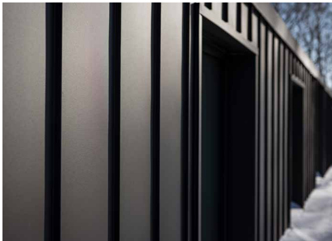
ФОТО HOUSE IN THE MOUNTAINS : МАТЕЙ ЛЮЛЬКО, ПОЛЬША. АВТОРСКОЕ ПРАВО: SSAB
