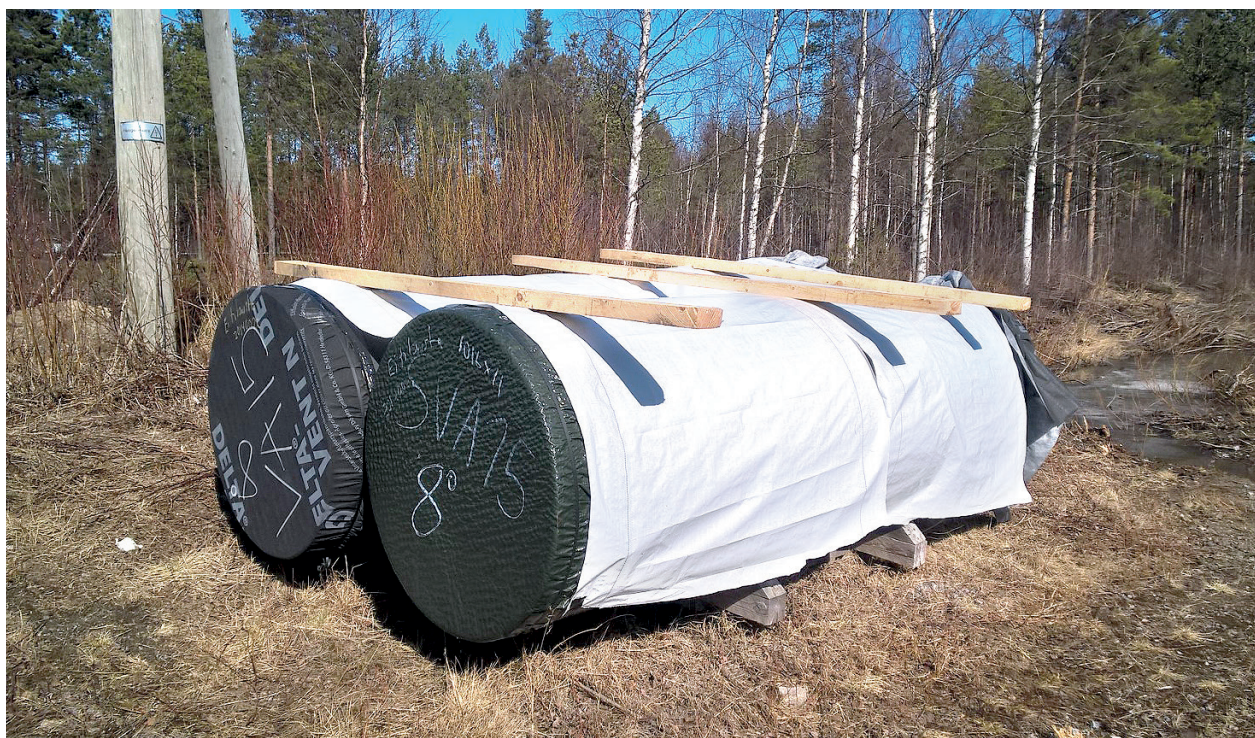
Figur 5. Rörändarna är skyddade med plastfilm, svarta rördelar skyddas med vit plast mot solen under sommartiden
